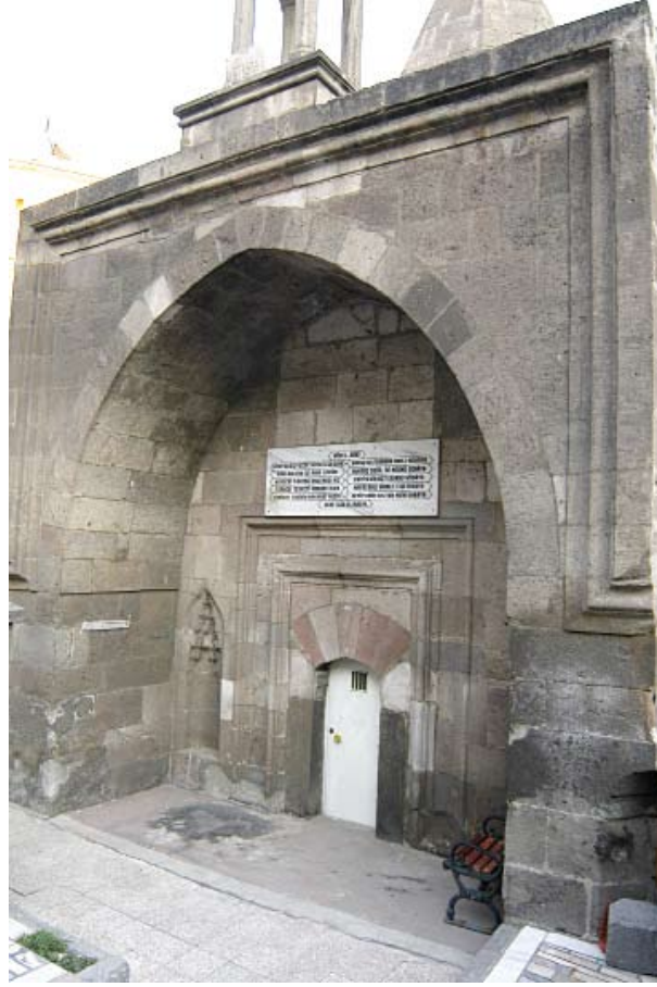
Emir Sultan Türbesi, giriş cephesinin görünümü.
