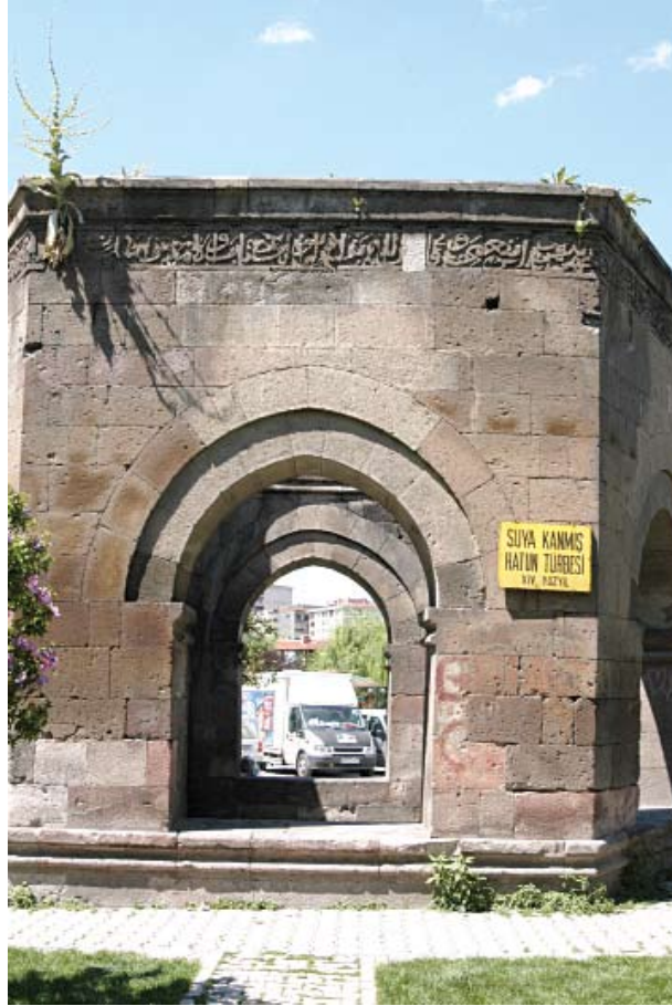
Suya Kanmış Hatun Türbesi içerden görünüşü.
