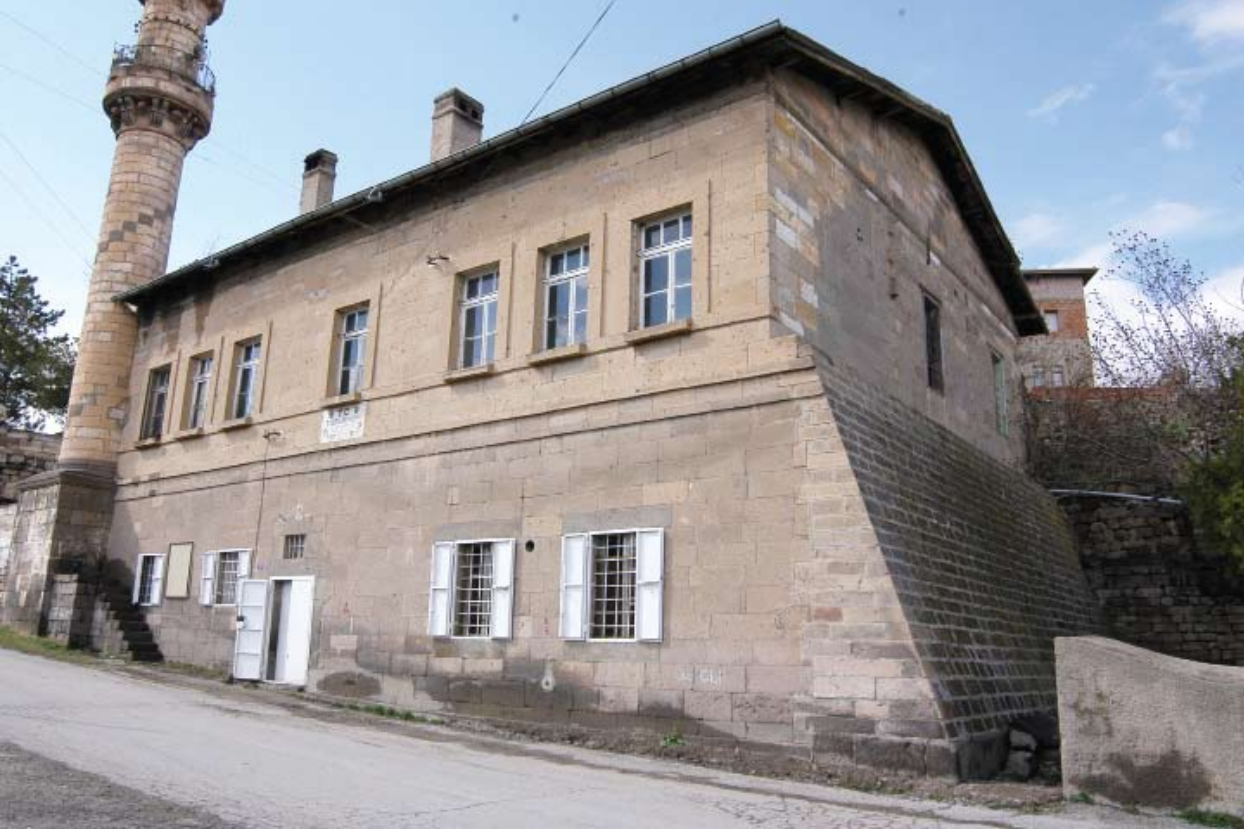
Tavlusun Köyü Mektebi, genel görünüş.
