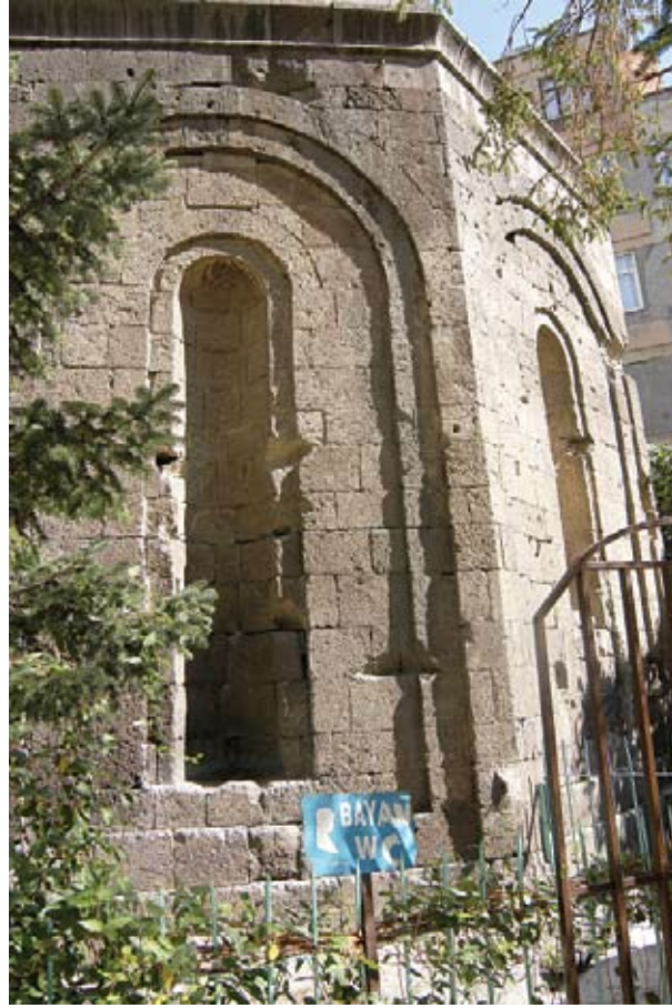
Anonim Türbe I, cephe nişinden detay.
