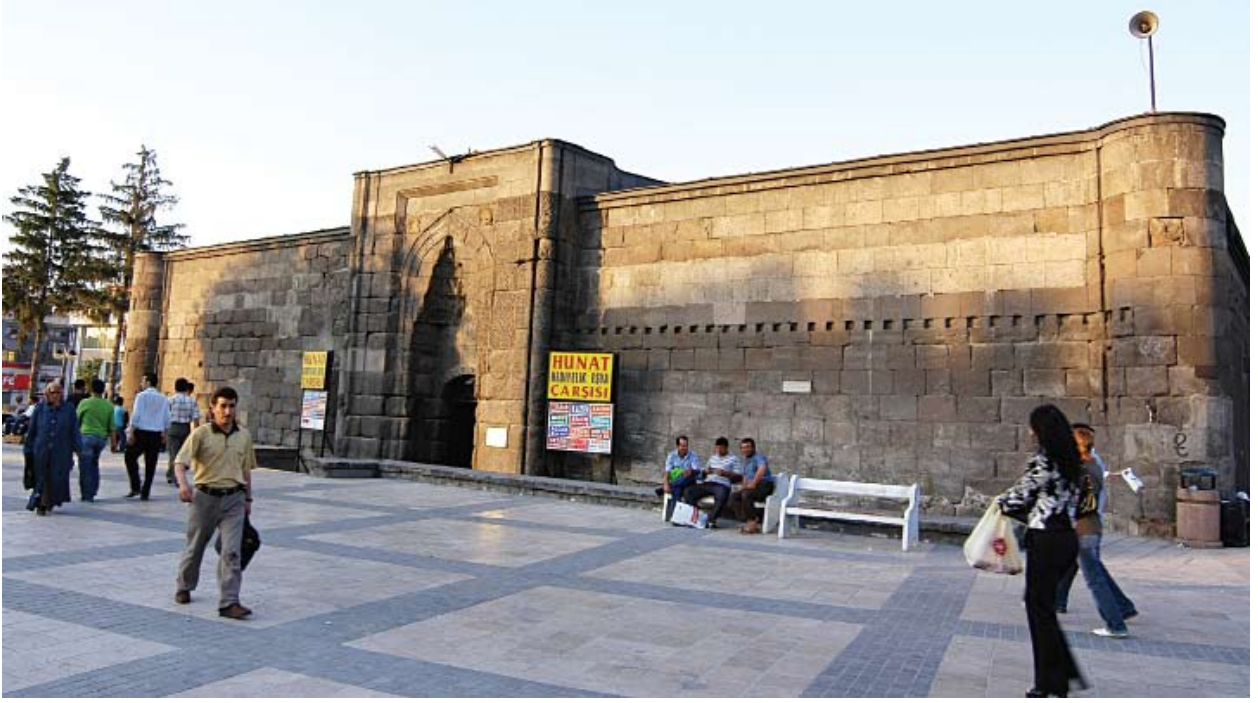
Hunat Hatun Medresesi, giriş (batı) cephesi.
