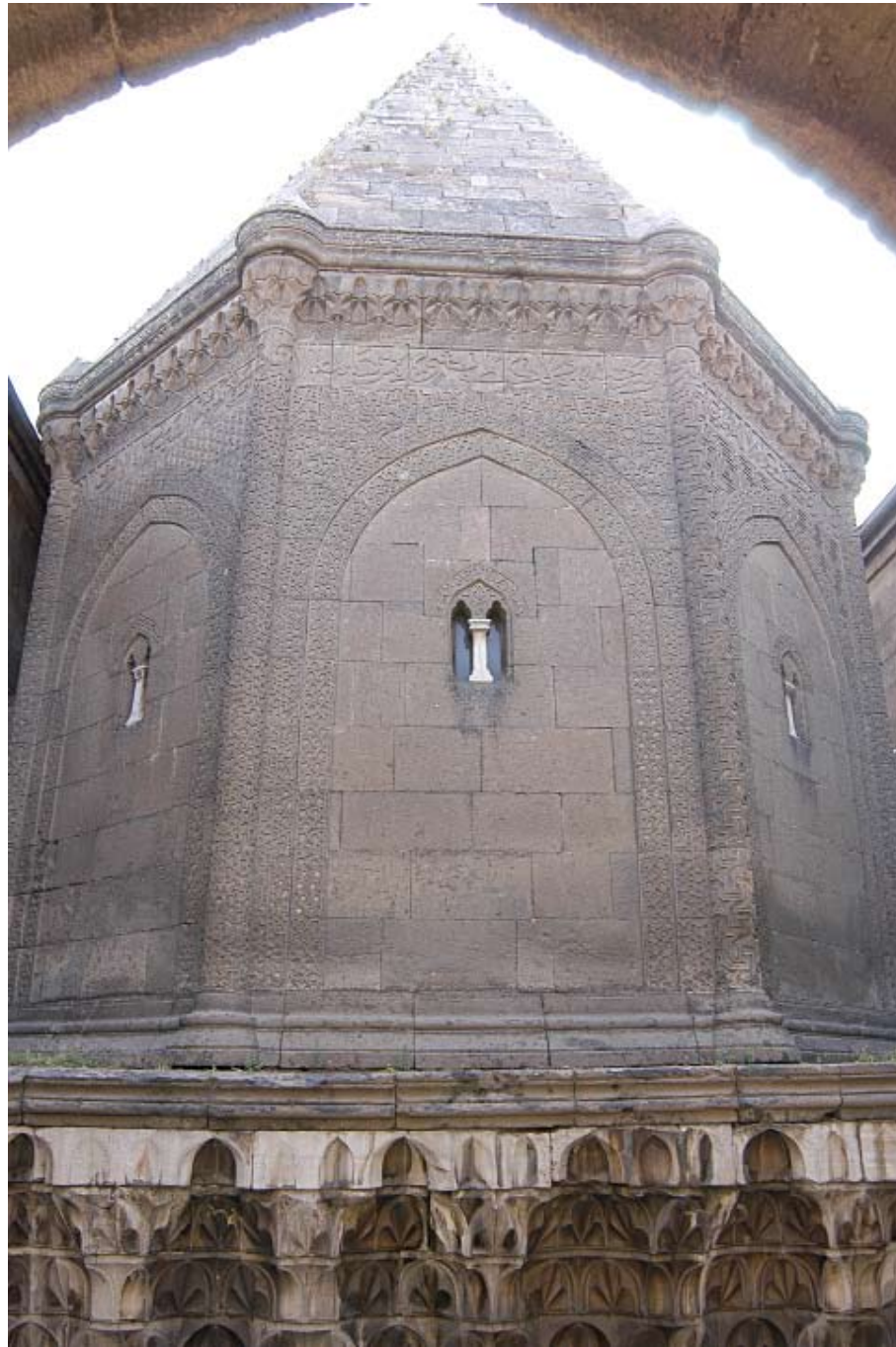
Hunat Hatun Türbesi, genel görünüş.
