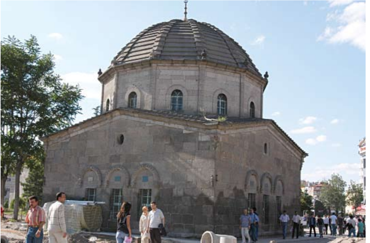
Zeynelabidin Türbesi, genel görünüş.
