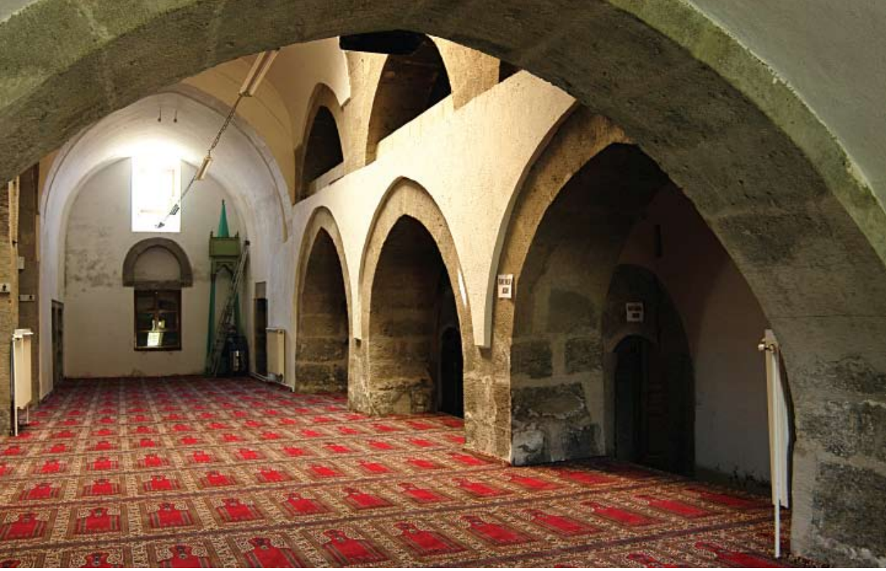
Gülük Cami ve Medresesi, revalıkları.
