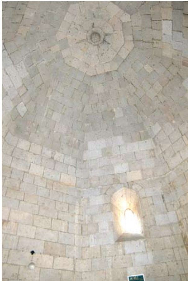
Süleyman Paşa Türbesi, kubbe.
