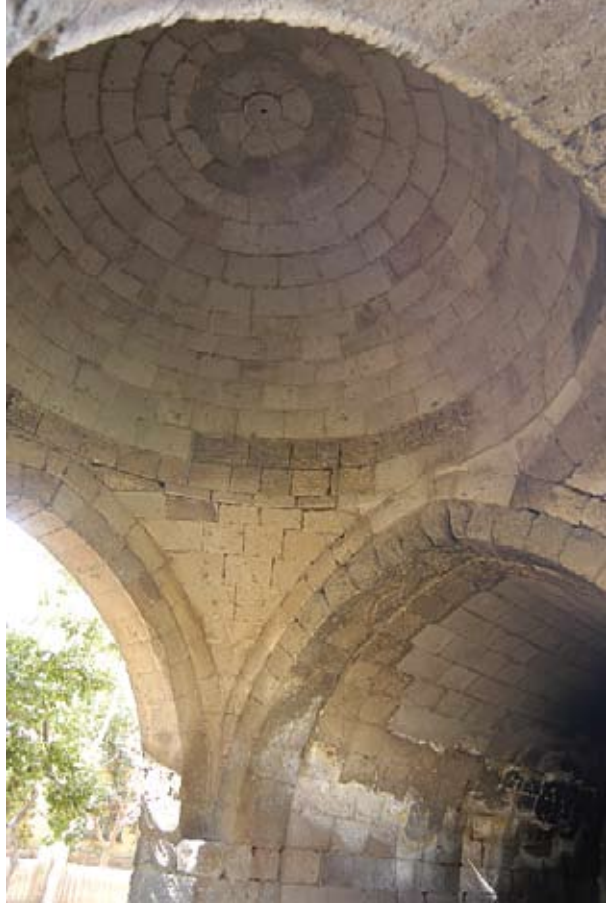
Dört Ayaklı Türbe, kubbenin içten görünüşü.
