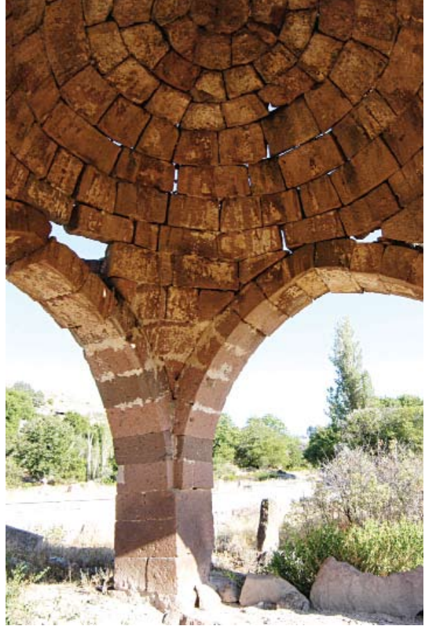
Molu Köyü Baldaken Türbe, kubbeden görüntü.
