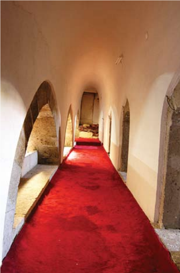
Güllük Medresesi, üst kat revağı.
