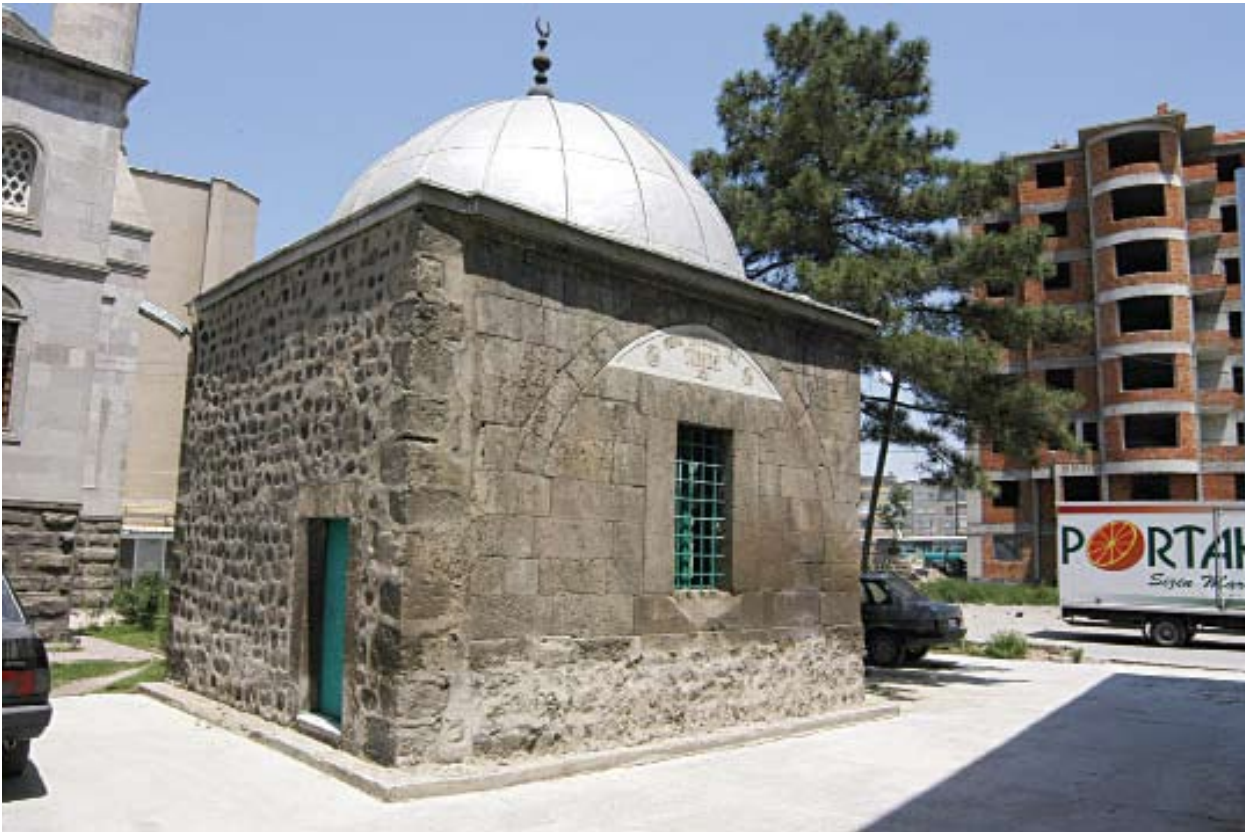
Tacettin Türbesi genel görünüş.
