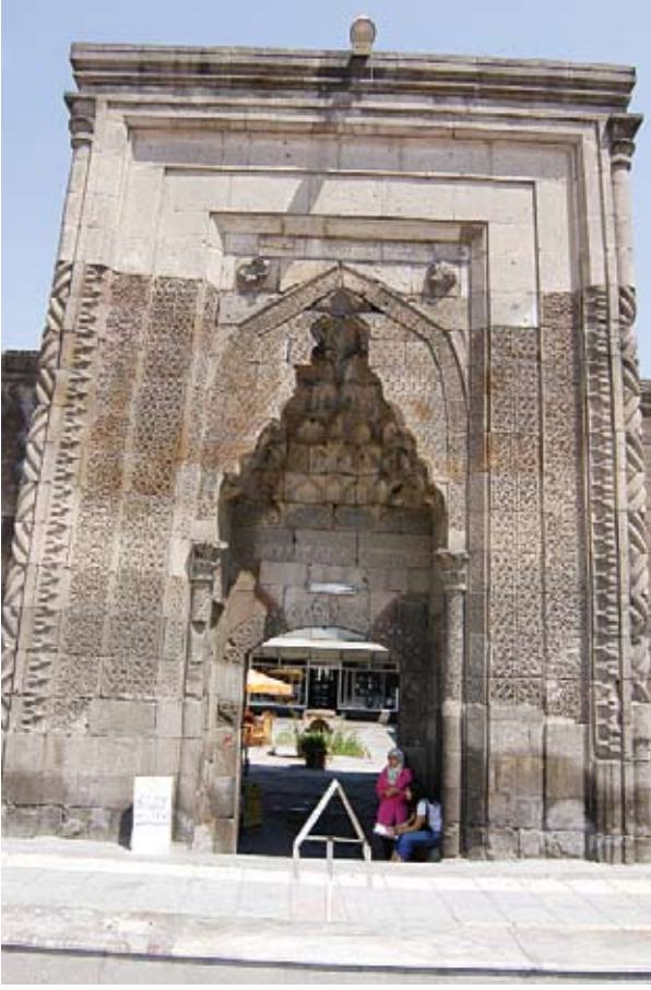
Sahabiye Medresesi, taçkapı.
