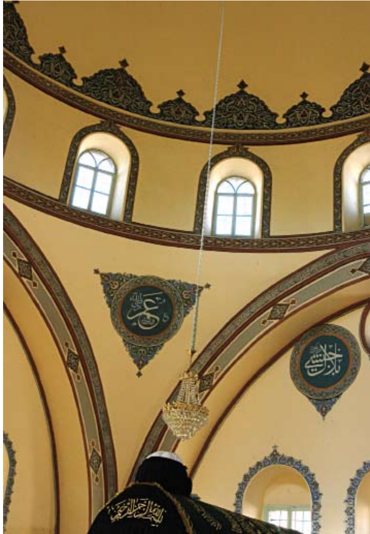
Zeynelabidin Türbesi, kubbeye geçiş ögesi.
