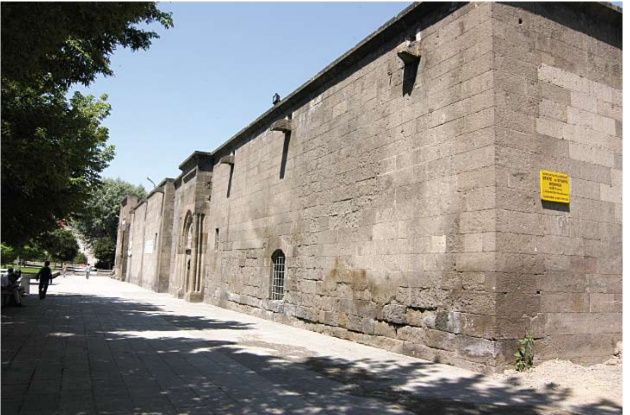
Çifte Medrese, güney cephe görünüş.
