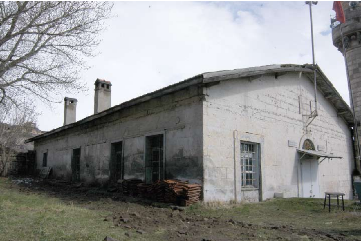
Tavlusun Köyü Mektebi, kuzey ve batı cepheler.
