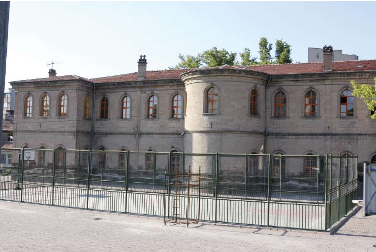
Kayseri Lisesi, arka (kuzey) cephe.
