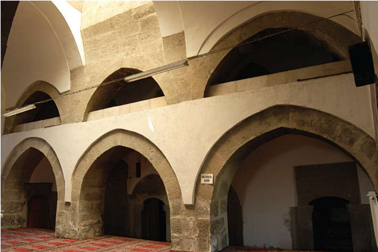
Gülük Cami ve Medresesi, revalıkları.
