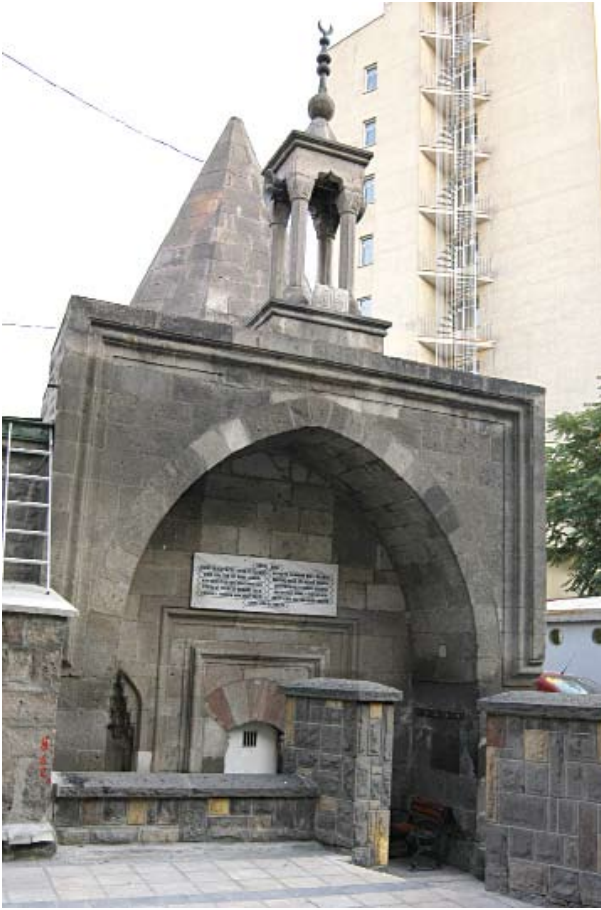
Emir Sultan Türbesi, giriş cephesinin görünümü.
