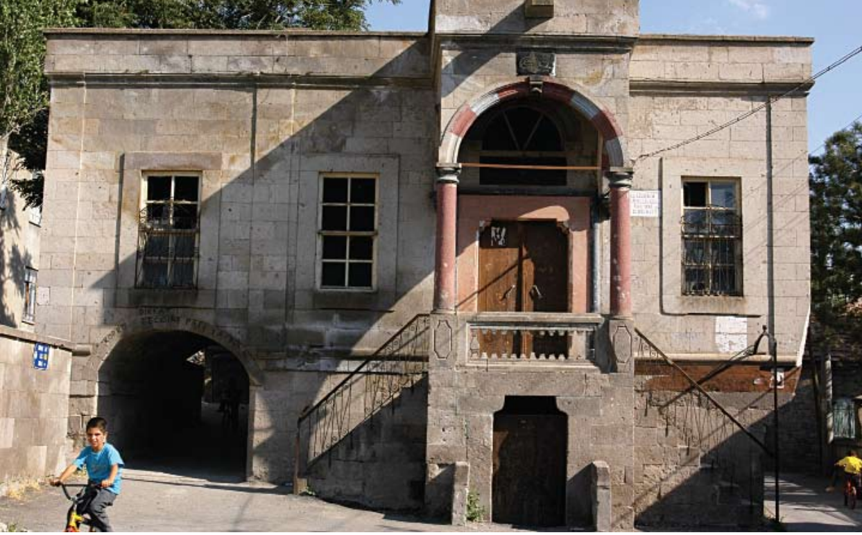
Germir Mektebi, giriş cephesi.
