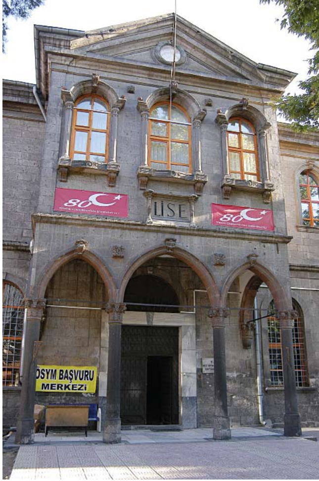
Kayseri Lisesi, giriş kapısı ve revağı.
