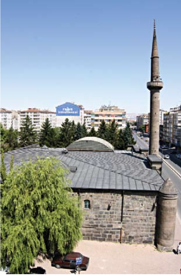
Hacı Kılıç Cami, güney cephe.
