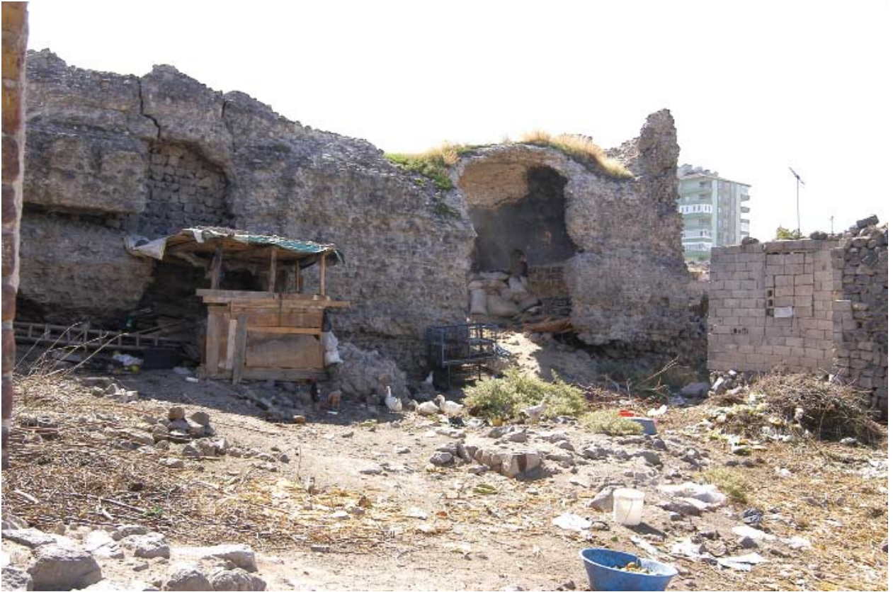
Kilise Kalıntısı, genel görünüş.
