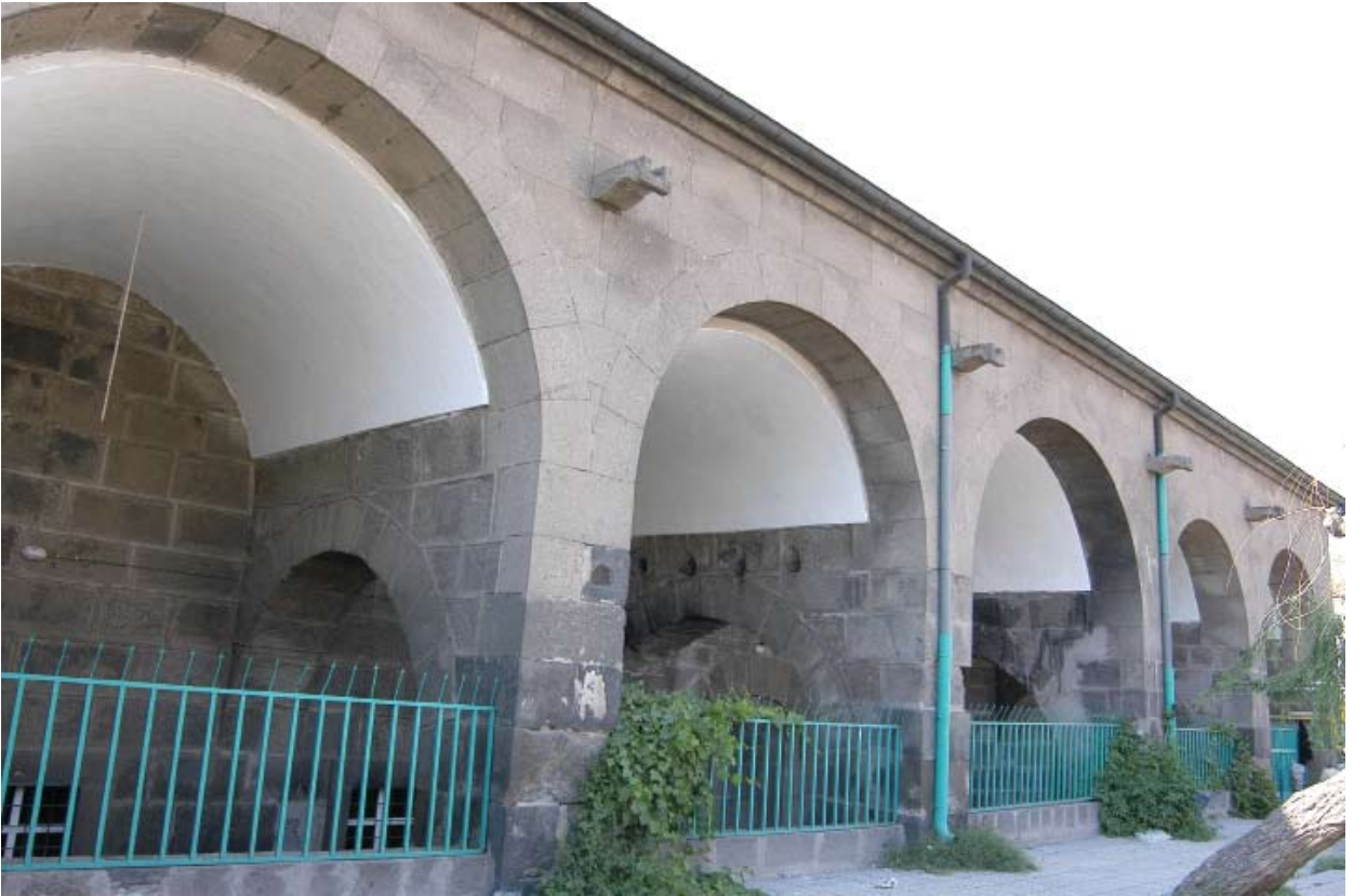
Han Cami, güney cephe.
