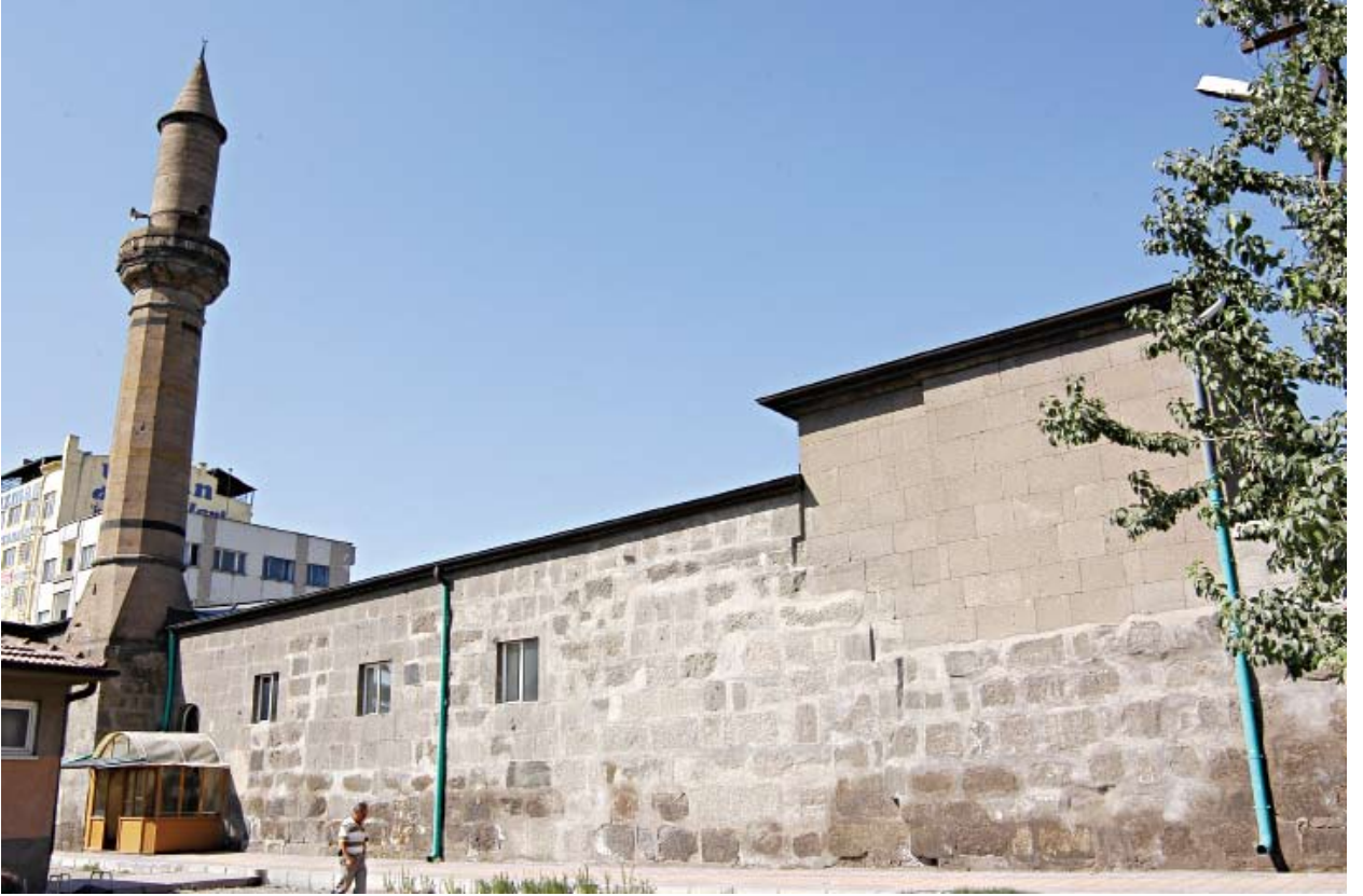
Han Cami, batı cephe.
