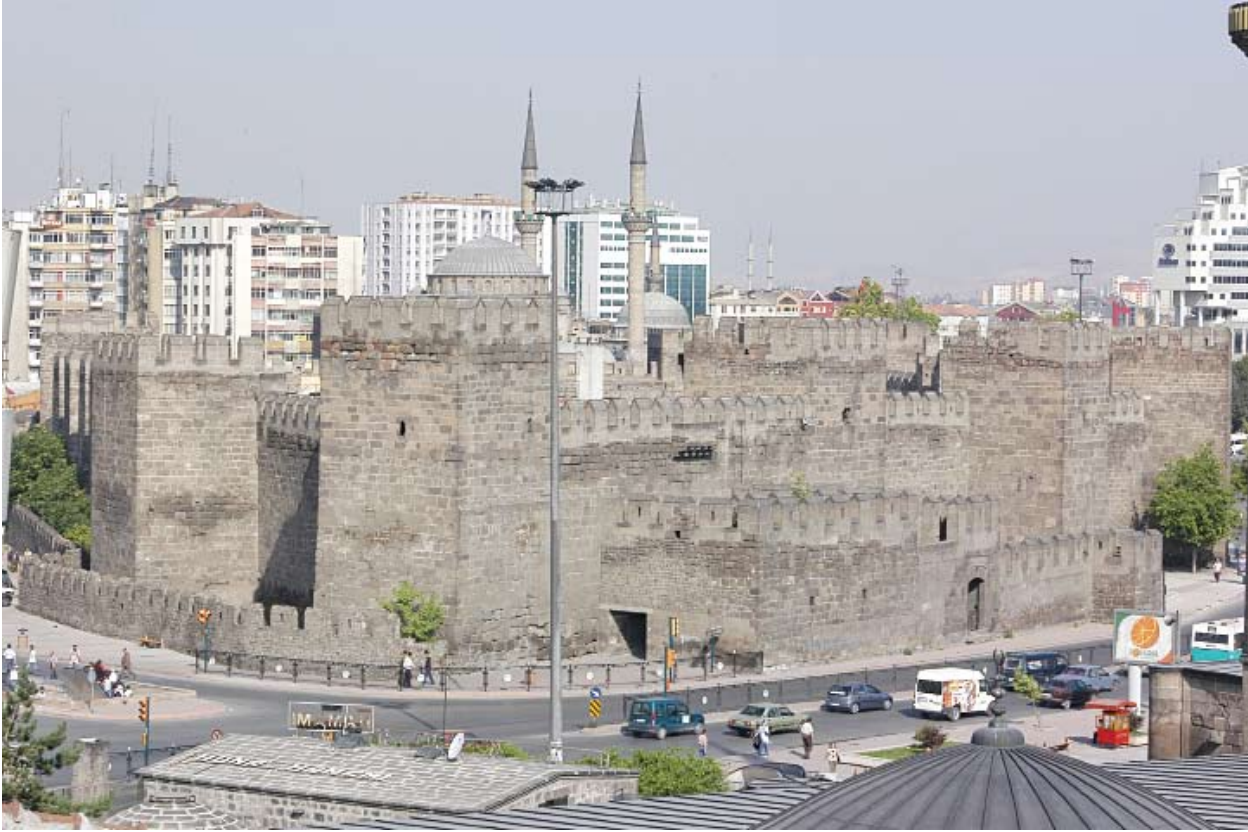
Kayseri Kalesi, genel görünüş.
