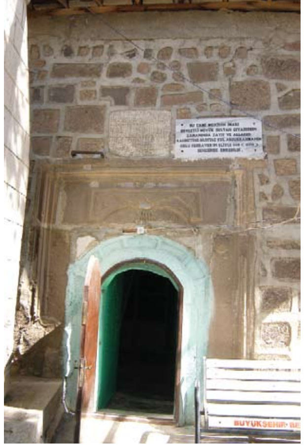
Yazır Köyü Cami, giriş kapısı.
