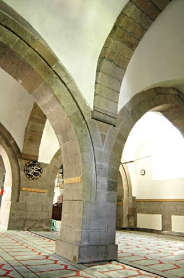
Hacı Kılıç Cami, iç mekan.
