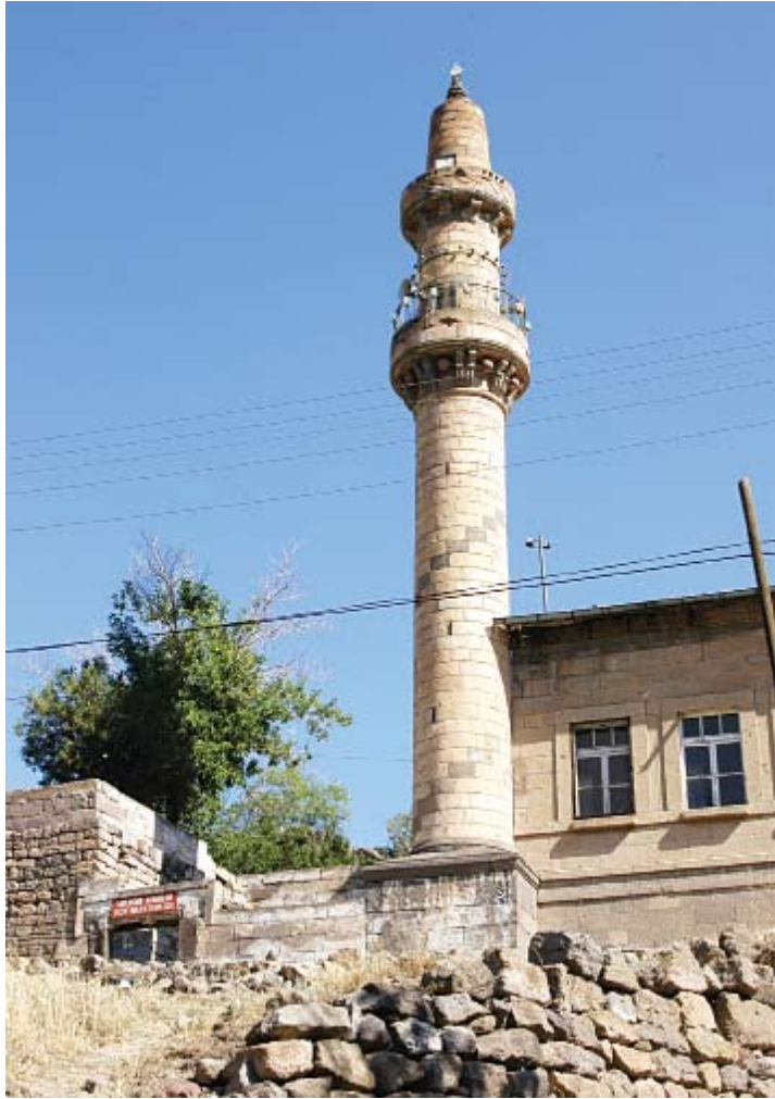
Tavlusun Orta Mahalle Cami, minare.
