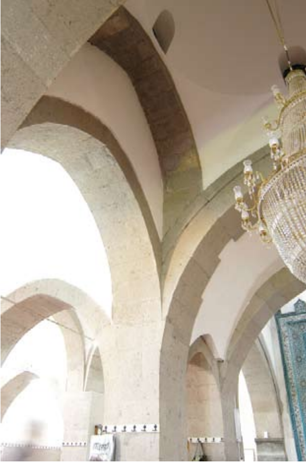
Güllük Cami, üst örtüden detay.
