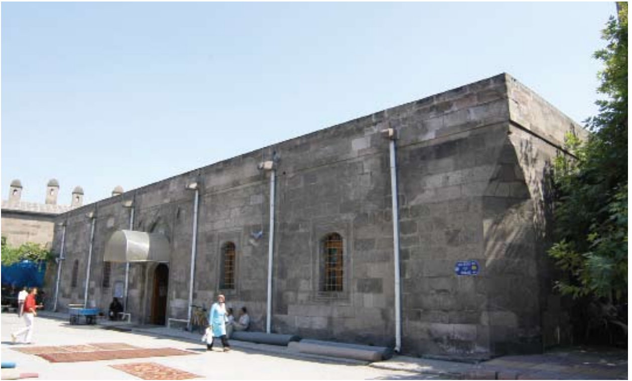
Kayseri Ulu Cami, kuzey cephe.
