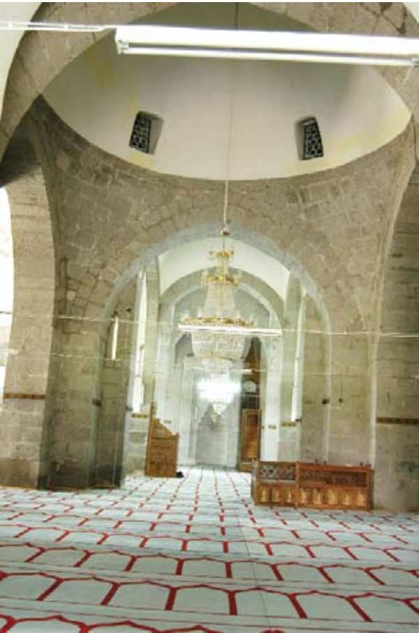
Lalapaşa Cami, iç mekan.
