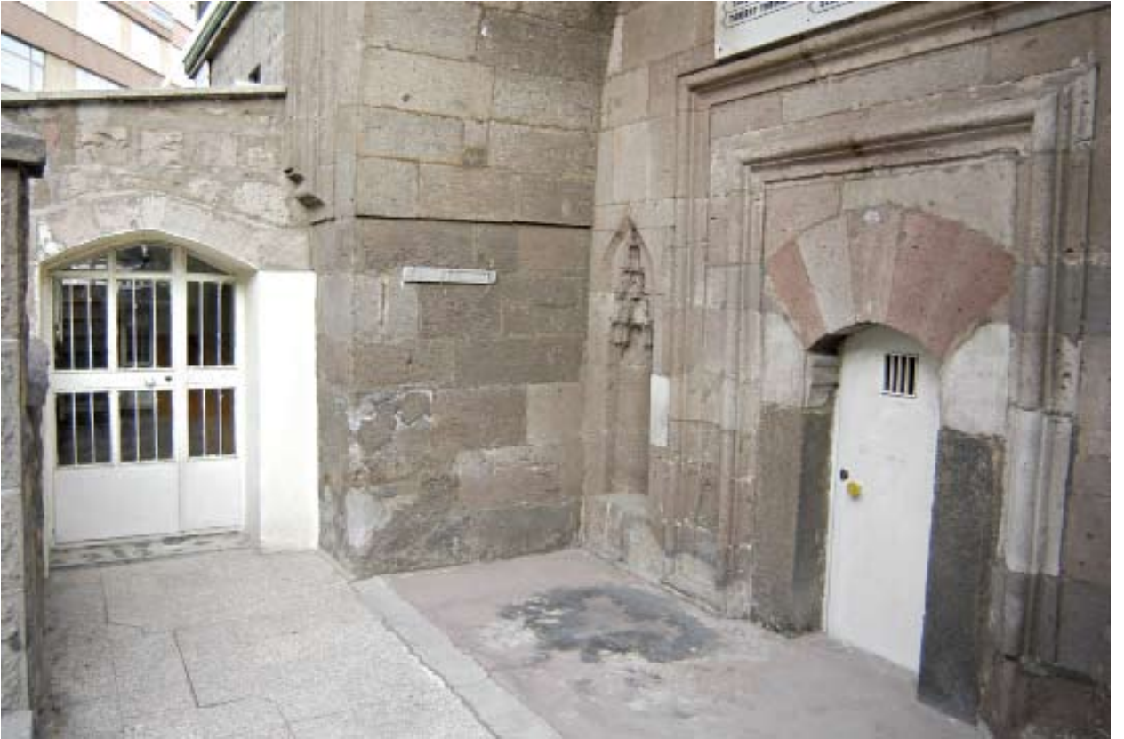
Emir Sultan Mescidi, giriş kapısı.
