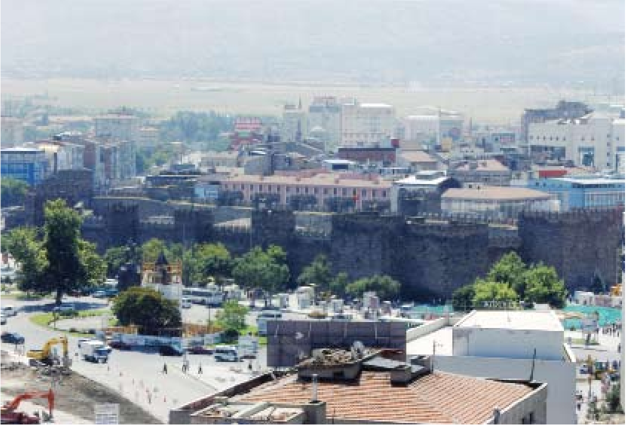
Kayseri Kalesi, genel görünüş.
