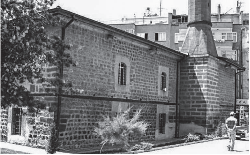
Resim 6. Yanıkoğlu Camii, Genel Görünüş (Kayseri Taşınmaz Kültür Varlıkları Envanteri, I, 154.)
