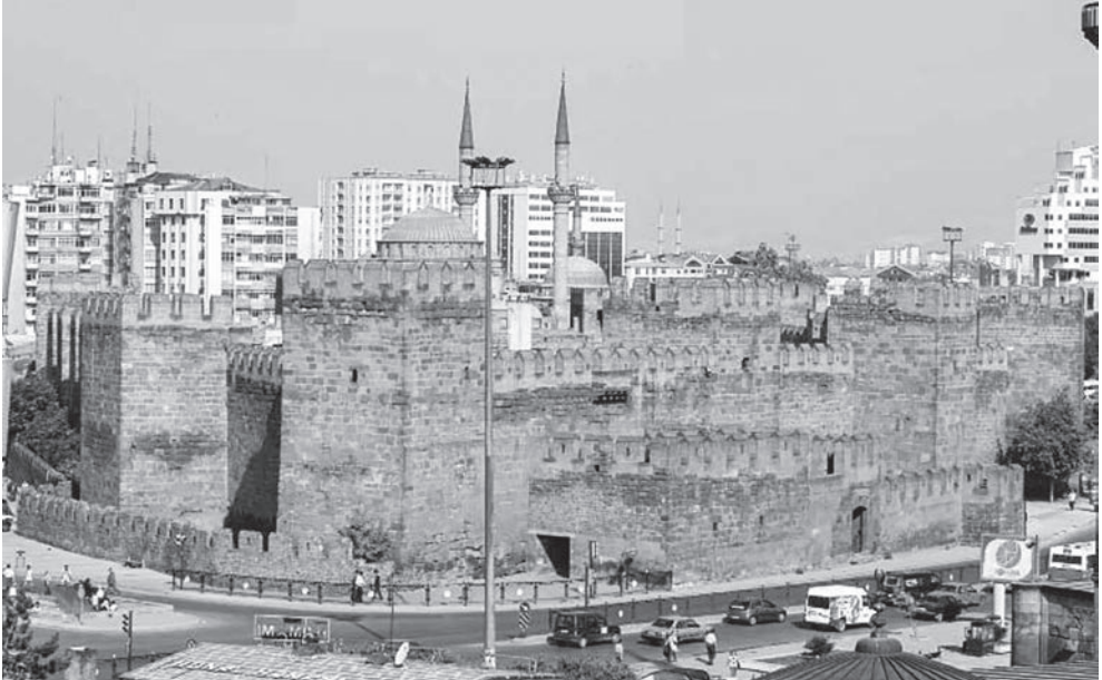
Resim 3. Kayseri Kalesi Dış Görünüş (Kayseri Taşınmaz Kültür Varlıkları Envanteri, I, 21.)
