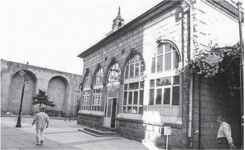
Resim 7. Cıncıklı (Çiğdeli) Camii, Genel Görünüş (Kayseri Taşınmaz Kültür Varlıkları Envanteri, I, 134.)
