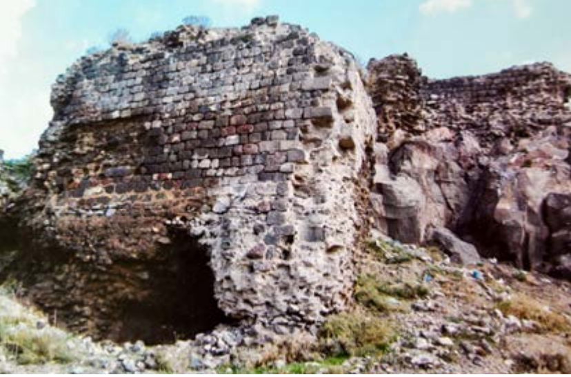
Eskişehir bölgesinde Karacaoğlu Mahallesi, Uluyol Sokağı ile Örentepe Sokağı arasındaki yamaçta bir kaya kütesine bitişik olarak devam eden sur parçası / Özbek Yıldırım-Arslan Celil, Kayseri Taşınmaz Kültür Varlıkları Envanteri , Kayseri Büyükşehir Belediyesi Yay., Kayseri 2008, C III, s. 12
