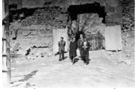
1987-88, İç Kale Kuzey Kapısının İnşaat Sebebiyle Açılması. Kayseri Valisi Yüksel Çavuşoğlu ve Belediye Başkanı Hüsamettin Çetinbulut (Ahmet Zorlu Kol.)
