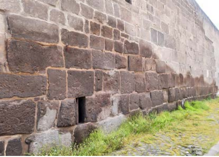
Andezit ve bazalt taşlardan oluşan sur duvarları
