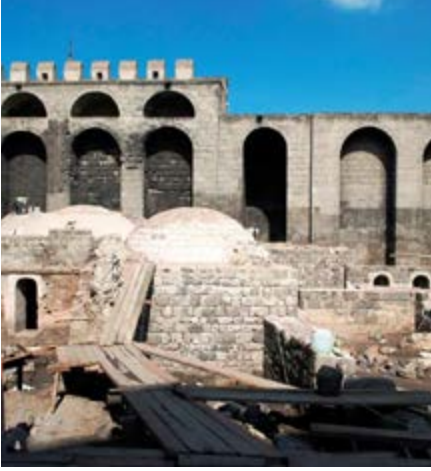
Çift Katlı Justinyanus Surları ve Sultan Hamamı Restorasyonu
