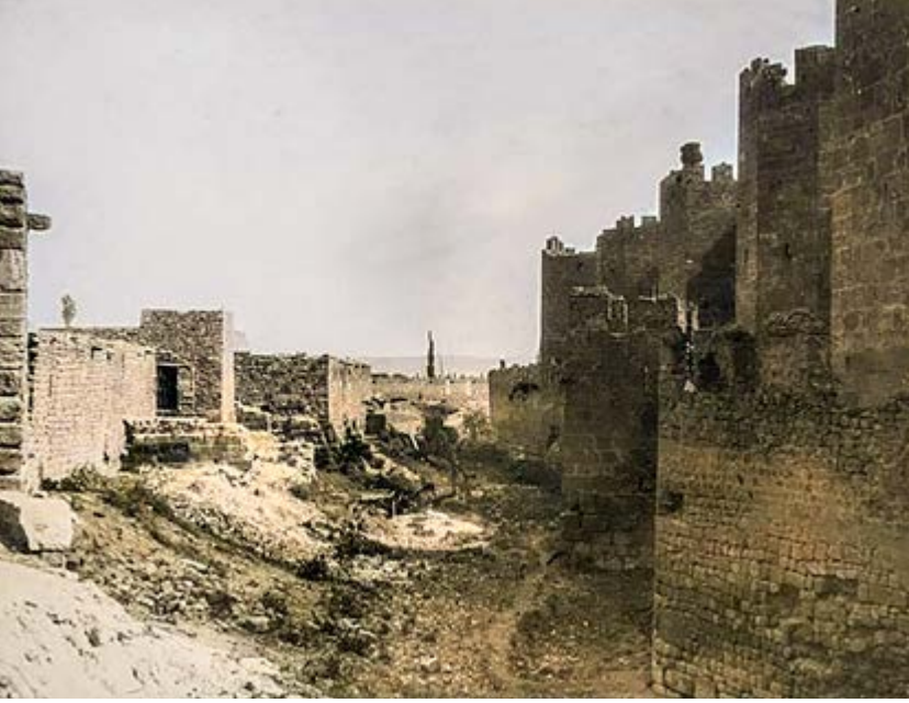
Kale hendeklerinin kapatılmadan önceki hali (1915'den önce)
