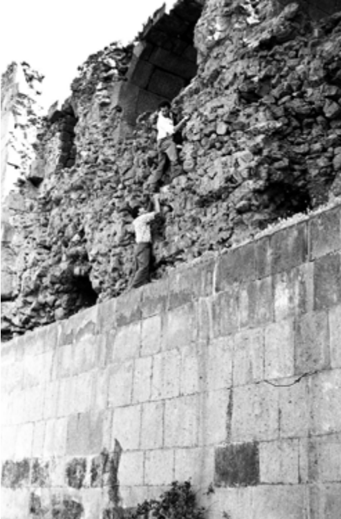
Duvarın dış yüzünde kesme taş, ortasındaysa dolgu maddesi olarak moloz taş kullanıldığı görülmektedir. (Ahmet Zorlu Kol)
