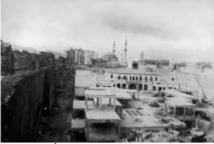
1988, Kale içinde Sarraflar Çarşısının yapımı (Recep Kanalgı-Kayham)
