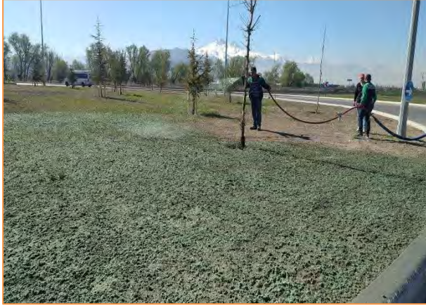
Bekir Yıldız Bulvarı Çim Tesisi
