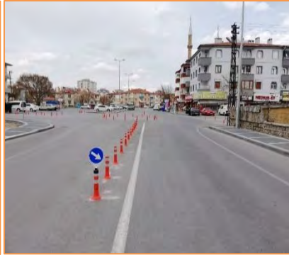
Delinatör ve Yol Butonu Montajı
