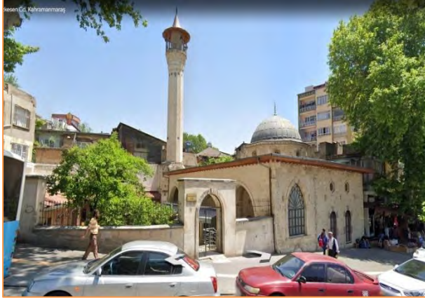
Deprem Öncesi Boğazkesen Camii
