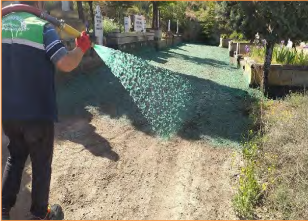
Asri Mezarlık Çim Püskürtme Çim Çalışması
