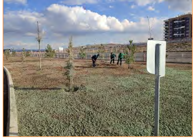
Şehir Hastanesi Yamaç Püskürtme Çim Çalışması
