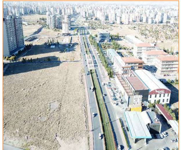
Kerkük Caddesi Asfalt Yenileme Çalışmaları
