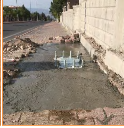
EDS Levha Ankraj ve Temel Betonu
