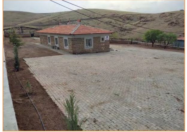
Tomarza Sosyal Tesisi Bahçesi Tesviye Çalışması
