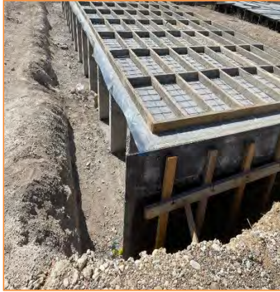
Mezarlık Duvarı Yapım ve Onarımı
