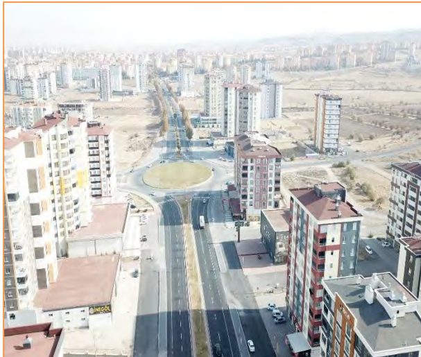
Malazgirt Bulvarı Asfalt Çalışmaları
