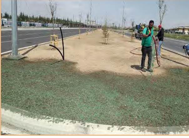
Millet Bahçesi Yanı Yol Püskürtme Çim Çalışması
