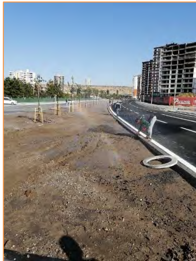
Germiralı Tesisat Çalışması
