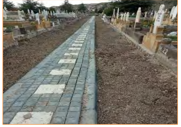
Asri Mezarlık Tesviye Çalışması
