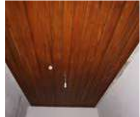
↑ Gavremoğlu Konağı'nın Yangın Geçirmiş Oda Tavanı, Restorasyon Sonrası (2023)
