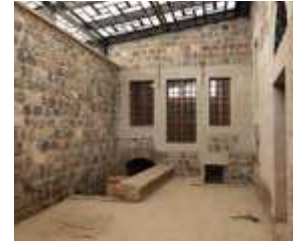
↑ Gavremoğlu Konağı'nın Güney Avlusu, Restorasyon Sonrası (2023)
