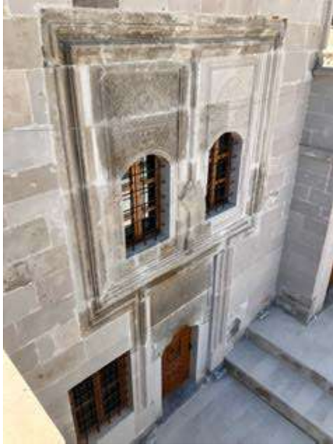
↑ Gavremoğlu Konağı'nın Kuzey Cephesi (Ana Giriş) (2022)
