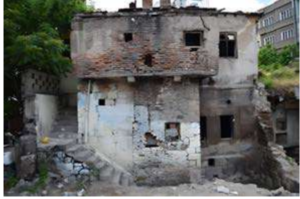
↑ Gavremoğlu Konağı'nın Giriş Cephesi, Restorasyon Öncesi (2018)
