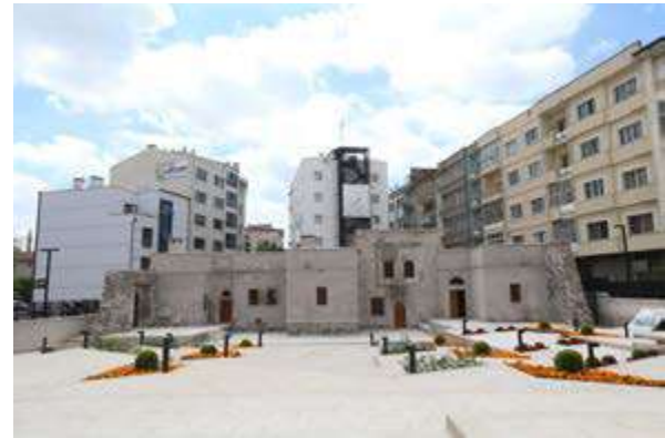
↑ Gavremoğlu Konağı'nın Kuzey Cephesi (Ana Giriş), Restorasyon Sonrası (2022)
