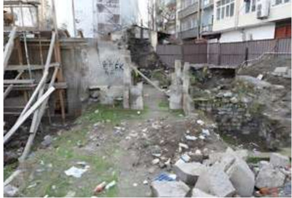
↑ Gavremoğlu Konağı'nın Giriş Cephesi, Restorasyon Öncesi (2018)
