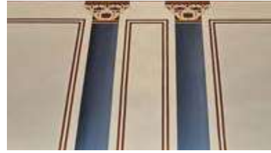
↑ Gavremoğlu Konağı Sofası Ahşap Duvar Zarı ve Kalem İşleri (2022)
