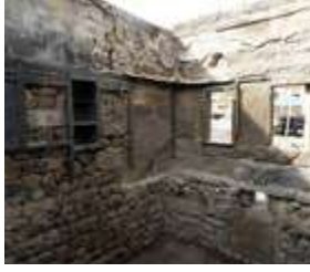
↑ Gavremoğlu Konağı'nın Odaları, Restorasyon Öncesi (2018)
