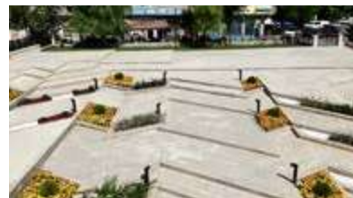
↑ Gavremoğlu Konağı Giriş Düzenlemesi (2022)
