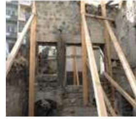
↑ Gavremoğlu Konağı'nın Güney Avlusu, Restorasyon Öncesi (2018)
