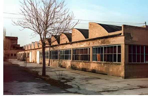
7. Kayseri Sümer Bez Fabrikası'nın üretim atölyelerinden biri, 20. yüzyıl ortalarındaki endüstriyel mimarinin yalın izlerini taşıyor. Tonoz çatılar ve uzun cam pencereler, doğal ışığı maksimumda kullanma hedefiyle inşa edilmişti. Bugün sessizliğe bürünmüş bu yapı, bir dönemin üretim ve emek hikâyesini duvarlarında saklamaya devam ediyor.
