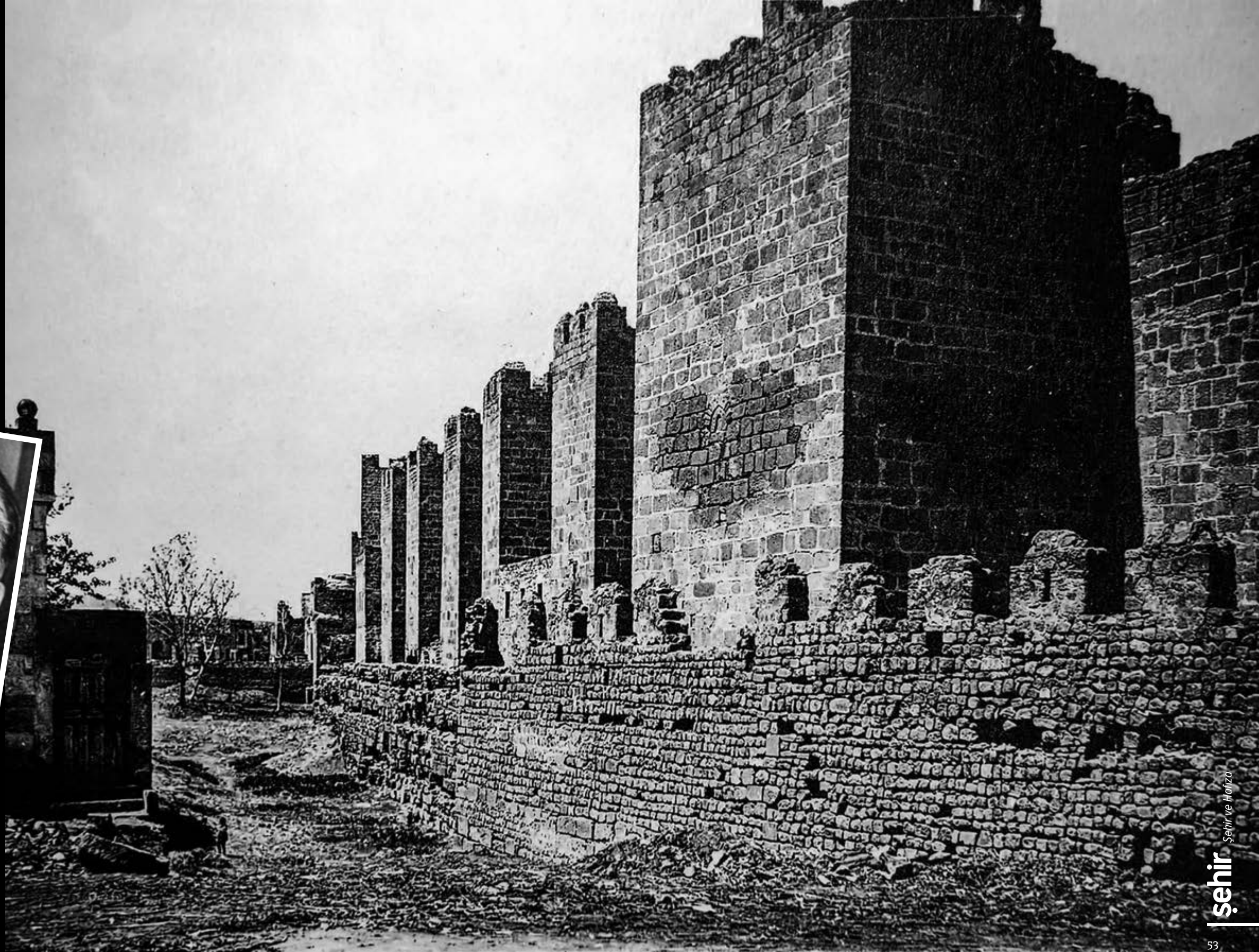
▲ Kale | Güney cephe perde duvarları ve kuleler
