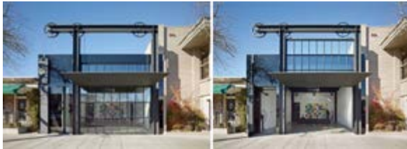
242 State Street Cephesinin Kapalı ve Açık Pozisyonu
