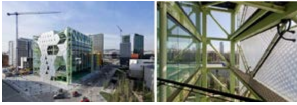
Media-TIC ve Cephe Sistemi.
