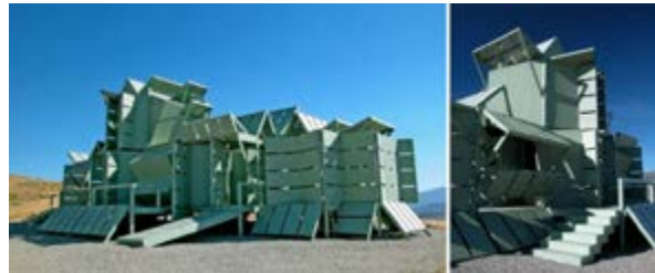
M-Evi Panelleri ve Menteşeli Hareketli Cephesi
