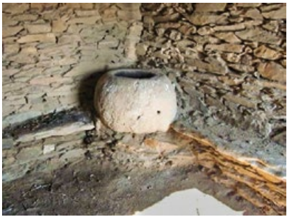
Fotoğraf 3: Oda Şekilli Musluklarda Köşeye Yerleştirilen Su Haznesi (Taş Testi) Fotoğraf: Hasan Kara, s.463, Fotoğraf 9.
