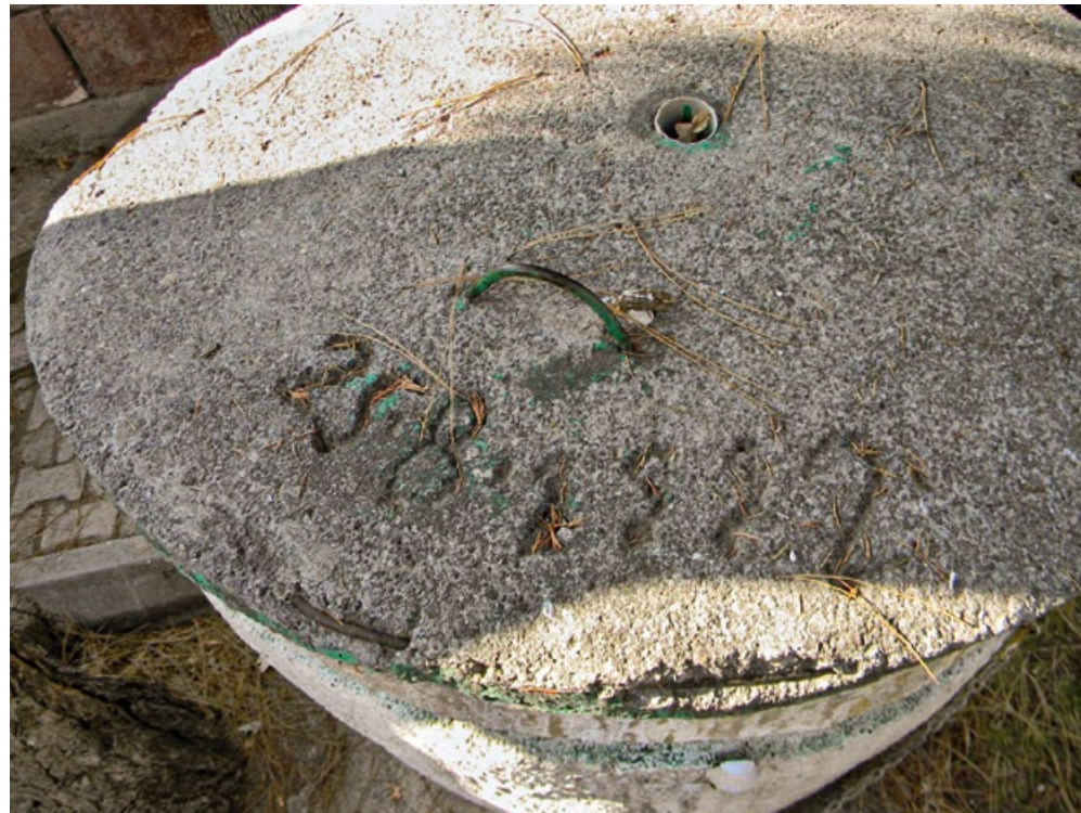
Fotoğraf 6: Taş Testi betonarme kapağı ve kapak üzerinde tarih yazısı.
