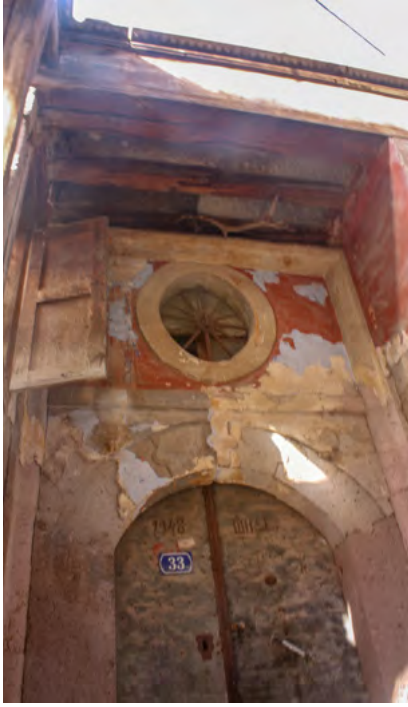
▲ Germir’de daire kesitli pencere örneği
