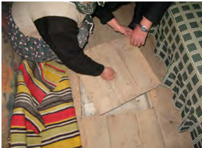
▲ b. İncesu’da tescilli Mehmet Kızıllık evinin üst katında yer alan yaşam odası/yatak odasında yer alan ahşap tandır. Mehmet Kızıllık ve eşinin anlattığına göre, tandır içerisinde toprak küp bulunmakta, ocakta yakılan ateş közlendikten sonra küpün içine doldurulmakta ve üzerinde iskembi kurularak etrafında sıcak alan oluşturulmaktadır. İncesu-Kayseri
