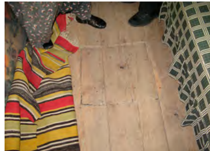
▲ b. İncesu’da tescilli Mehmet Kızıllık evinin üst katında yer alan yaşam odası/yatak odasında yer alan ahşap tandır. Mehmet Kızıllık ve eşinin anlattığına göre, tandır içerisinde toprak küp bulunmakta, ocakta yakılan ateş közlendikten sonra küpün içine doldurulmakta ve üzerinde iskembi kurularak etrafında sıcak alan oluşturulmaktadır. İncesu-Kayseri
