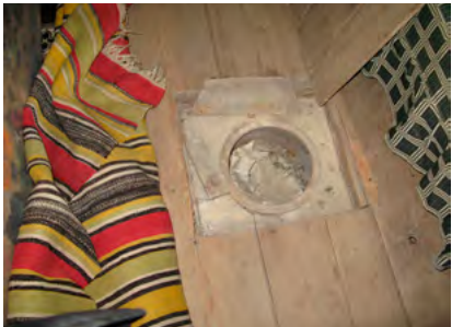
▲ b. İncesu’da tescilli Mehmet Kızıllık evinin üst katında yer alan yaşam odası/yatak odasında yer alan ahşap tandır. Mehmet Kızıllık ve eşinin anlattığına göre, tandır içerisinde toprak küp bulunmakta, ocakta yakılan ateş közlendikten sonra küpün içine doldurulmakta ve üzerinde iskembi kurularak etrafında sıcak alan oluşturulmaktadır. İncesu-Kayseri
