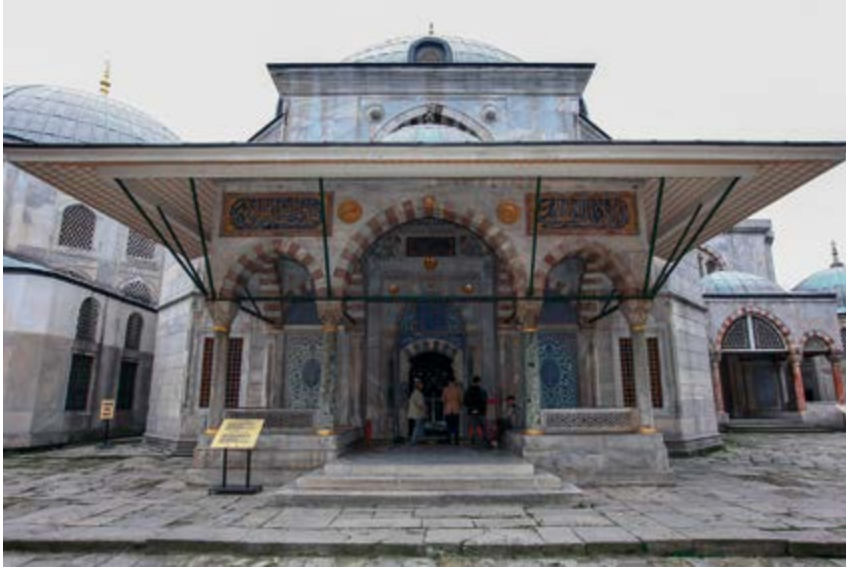
▲ Sultan İkinci Selim Türbesi
